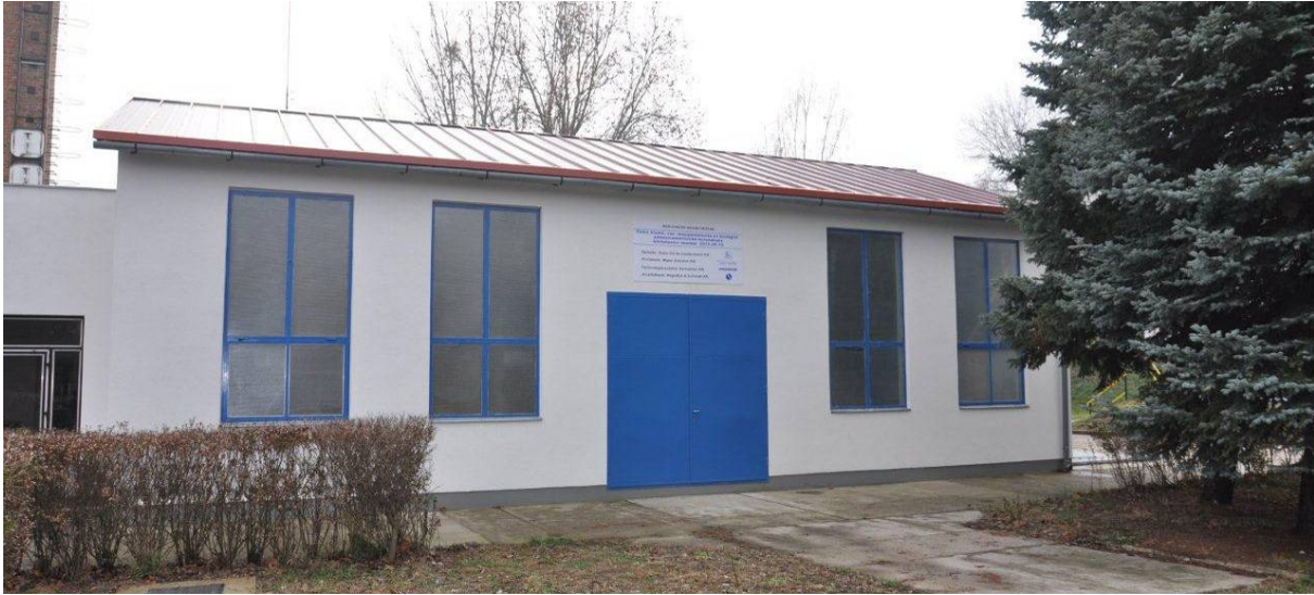
Buitenkant van het Tolna waterbedrijf
