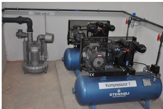
Rechts: Beluchtingsysteem met compressors. Links: Filtratie systeem met EUROWATER drukfilters Luchtblower voor optimale backwash
