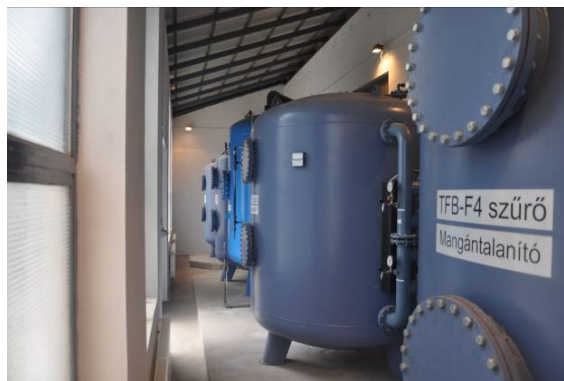
Rechts: Beluchtingsysteem met compressors. Links: Filtratie systeem met EUROWATER drukfilters Luchtblower voor optimale backwash
